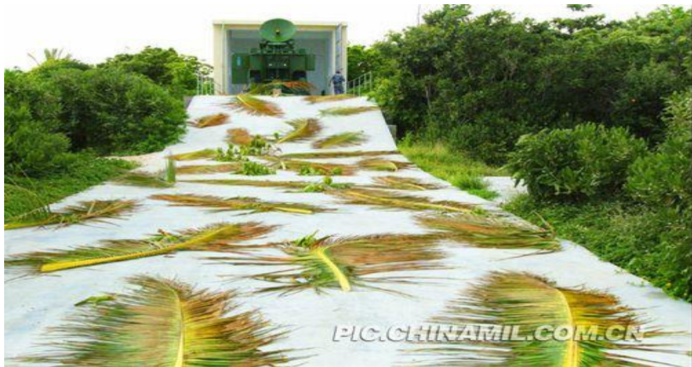
Một hệ thống Radar đặt trên đảo
